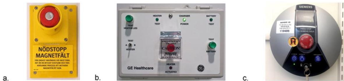
Figur 9. Nödstopp/quenchknapp (röd knapp) för Magnetfältet för tre olika leverantörer av utrustningar. a) Philips , b) GE och c) Siemens .
