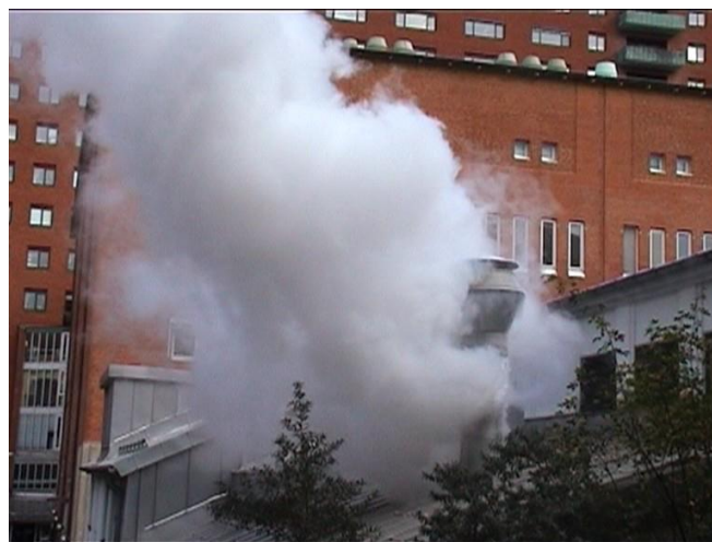
Figur 10. Quench. Heliumgas strömmar ut ur quenchröret på taket.
