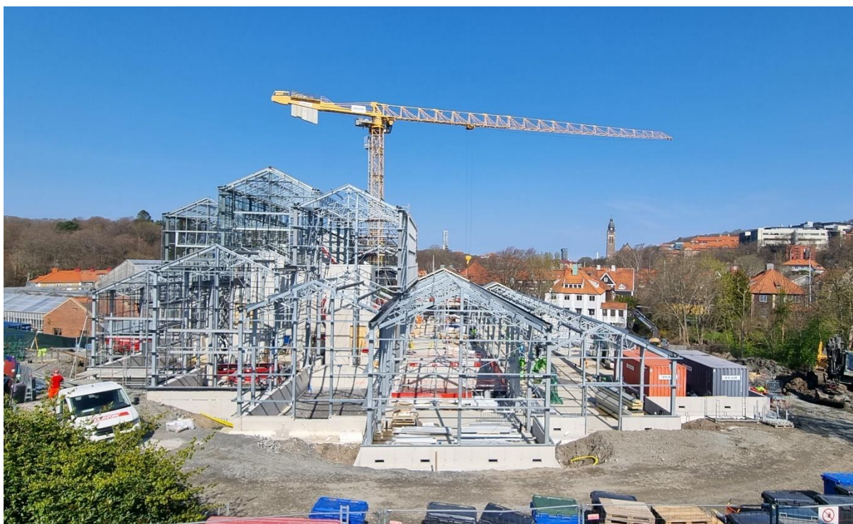
Bild 1. Översiktsbild arbetsområde etapp 2
