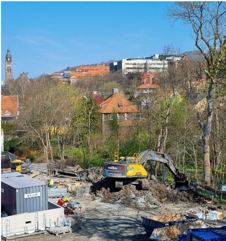
Bild 2. Pågående schakt- och pålningsarbete i öster
