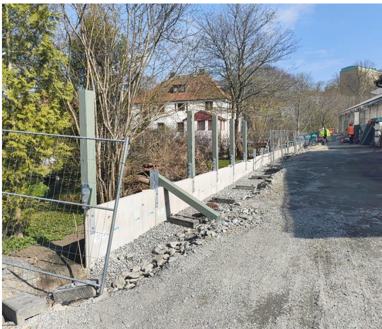
Bild 3. Pågående byggnation av plank
