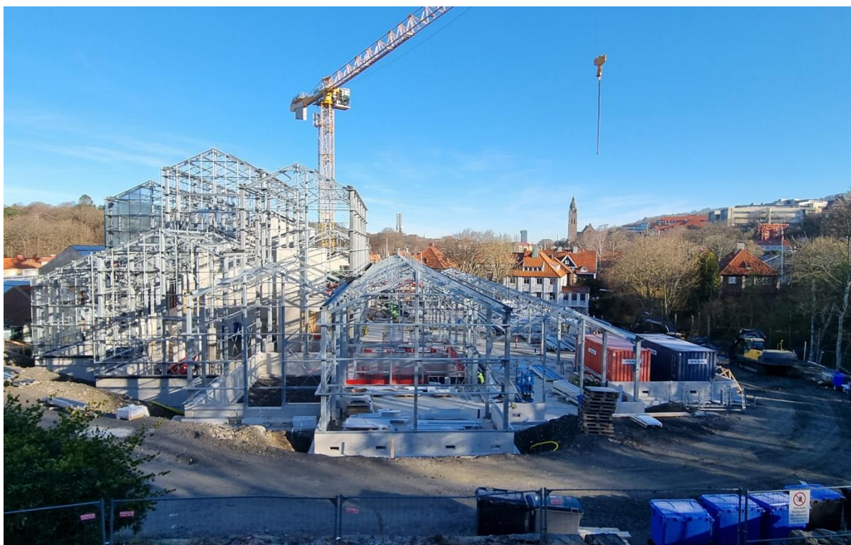
Bild 1. Översiktsbild arbetsområde etapp 2
