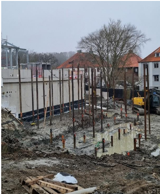
Bild 2. Pågående schakt- och pålningsarbete i öster
