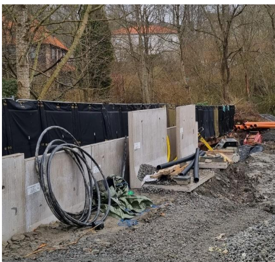
Bild 3. Monterade L-stöd i tomtgräns.
