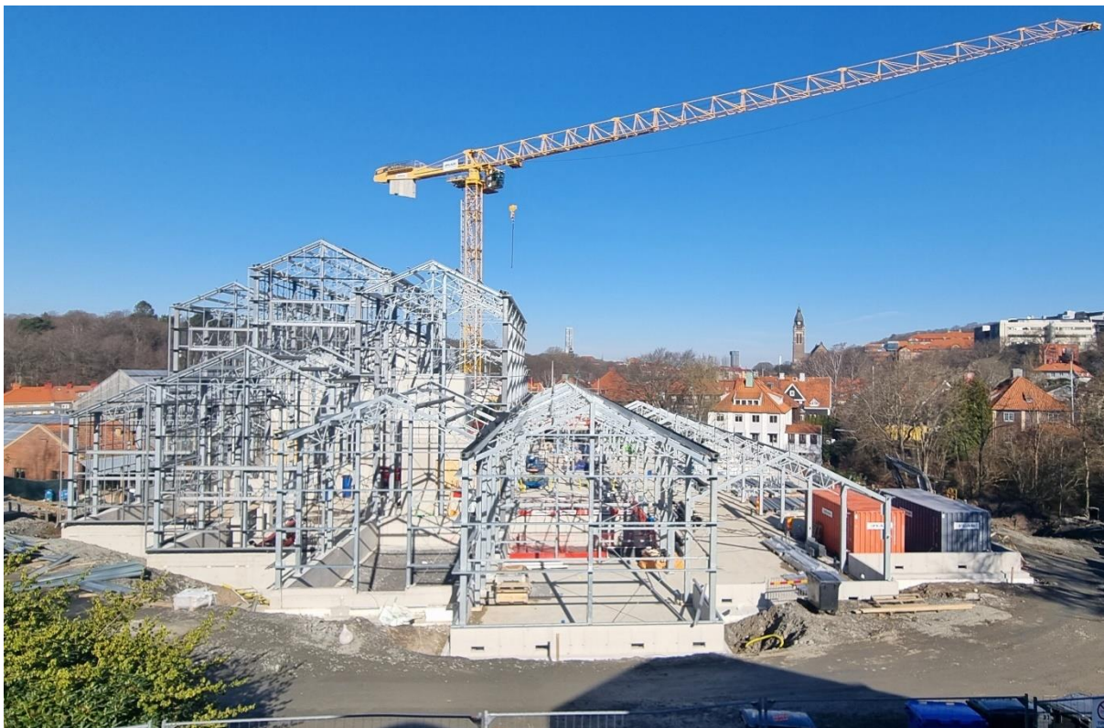
Bild 1. Översiktsbild arbetsområde etapp 2
