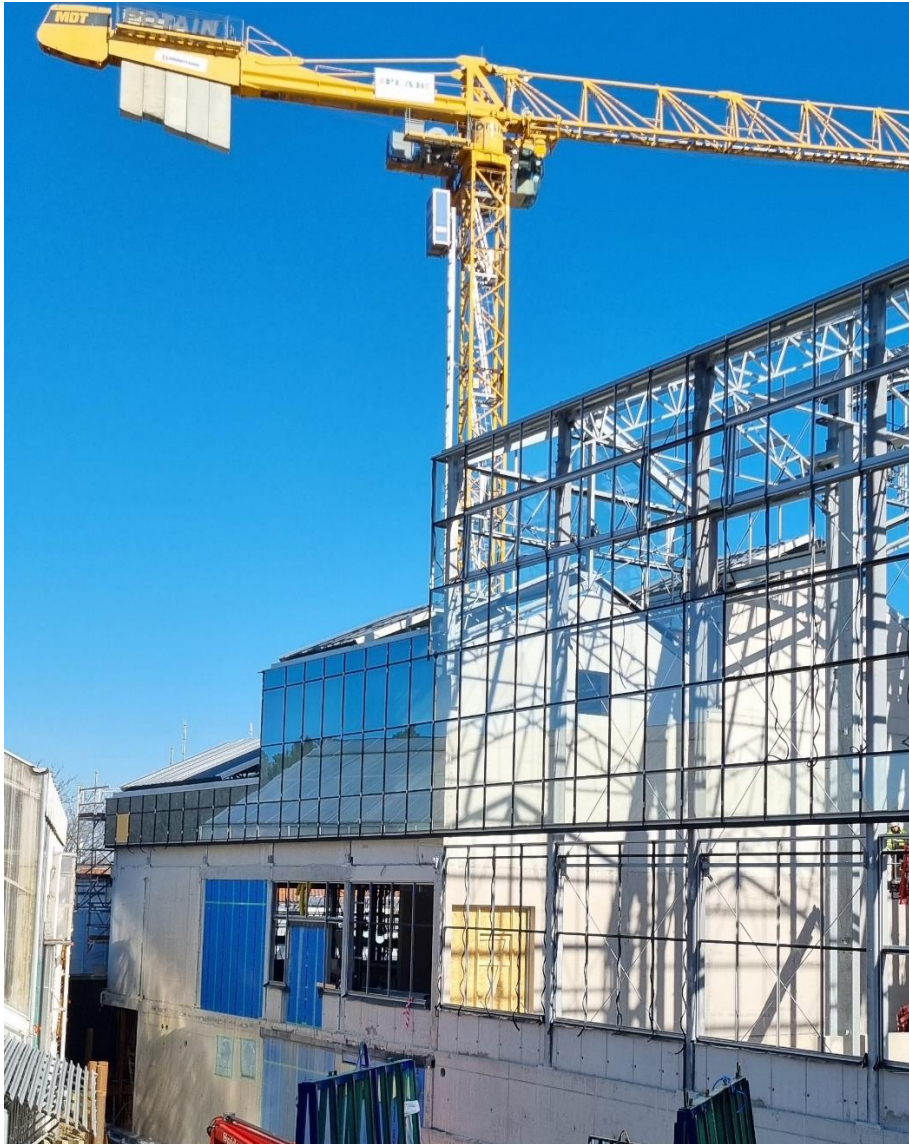
Bild 2. Glasning av fasad mot Fanny Gréns väg påbörjad
