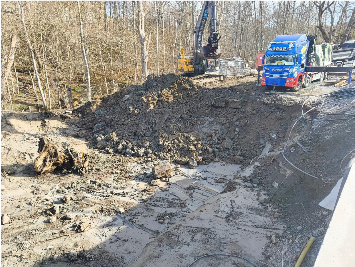
Bild 3. Pågående schaktarbete i öster
