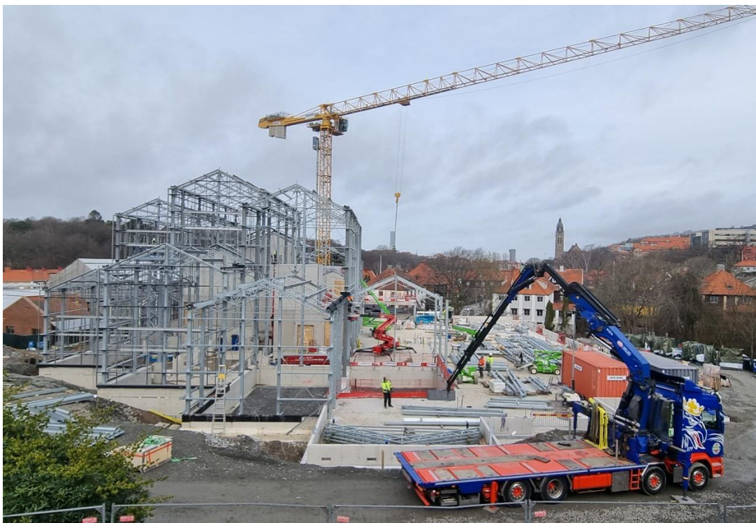
Bild 1. Översiktsbild arbetsområde etapp 2
