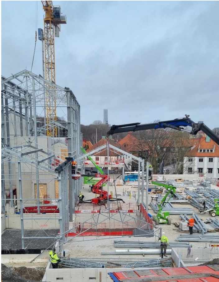
Bild 2. Pågående arbete med montering takstol
