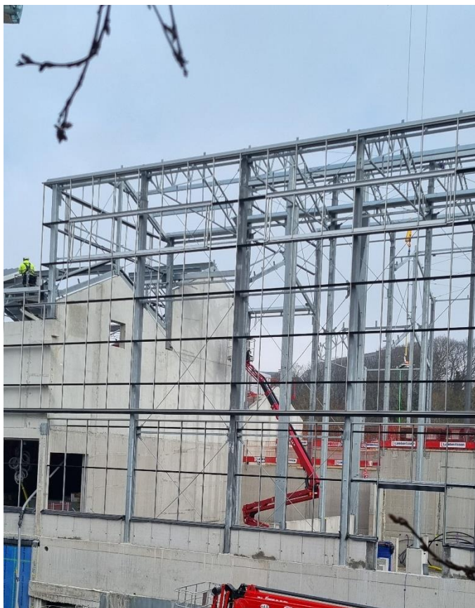
Bild 2. Växthusstomme med profiler förberedda för glasing
