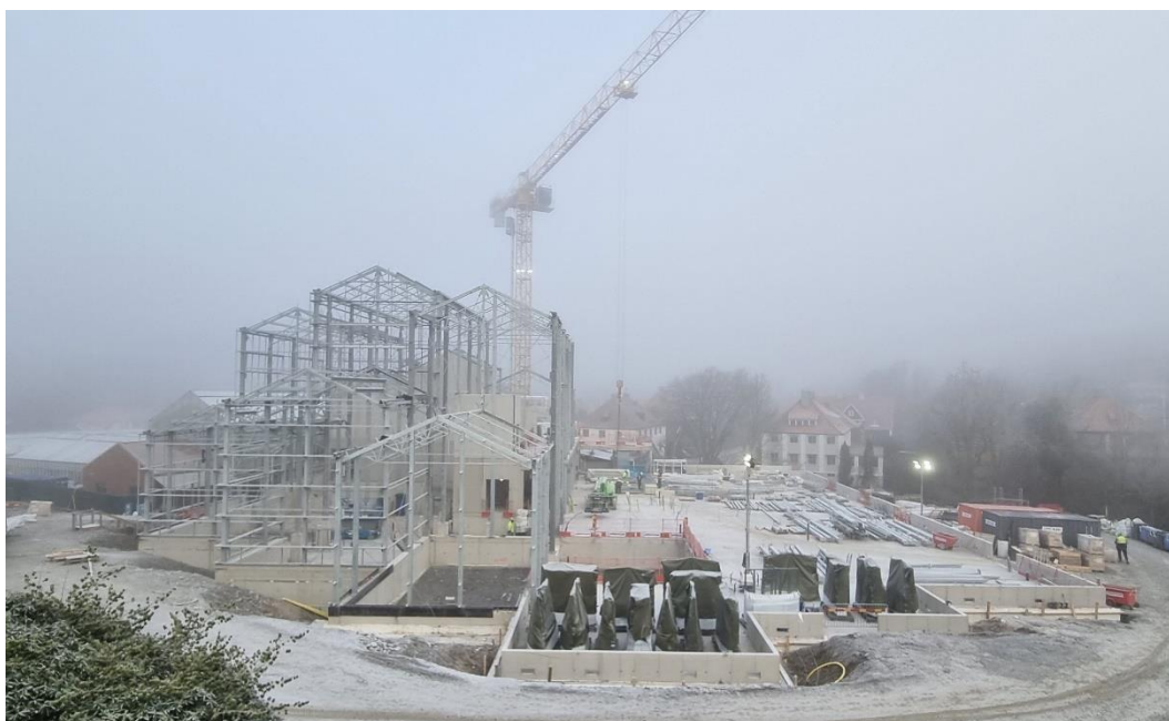
Bild 1. Översiktsbild arbetsområde etapp 2
