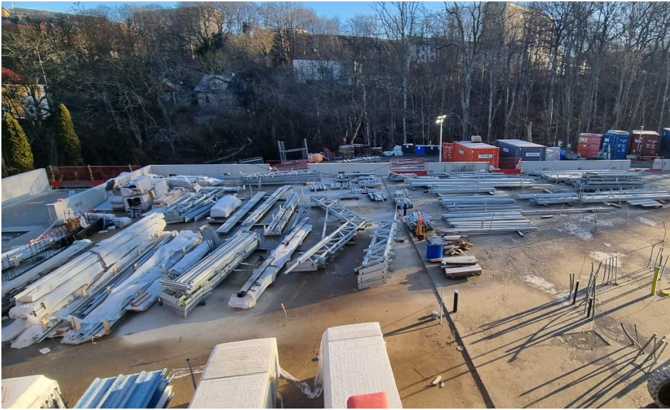
Bild 2. Delar till stålstomme växthus som väntar på montage
