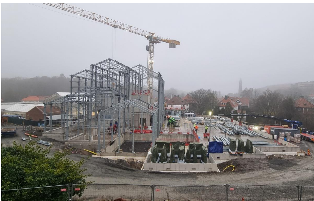
Bild 1. Översiktsbild arbetsområde etapp 2
