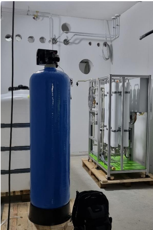
Bild 3. Pågående installation vattensystem
