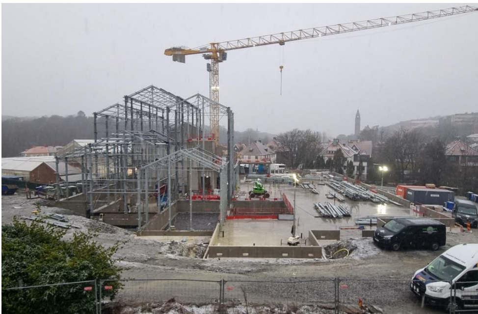
Bild 1. Översiktsbild arbetsområde etapp 2
