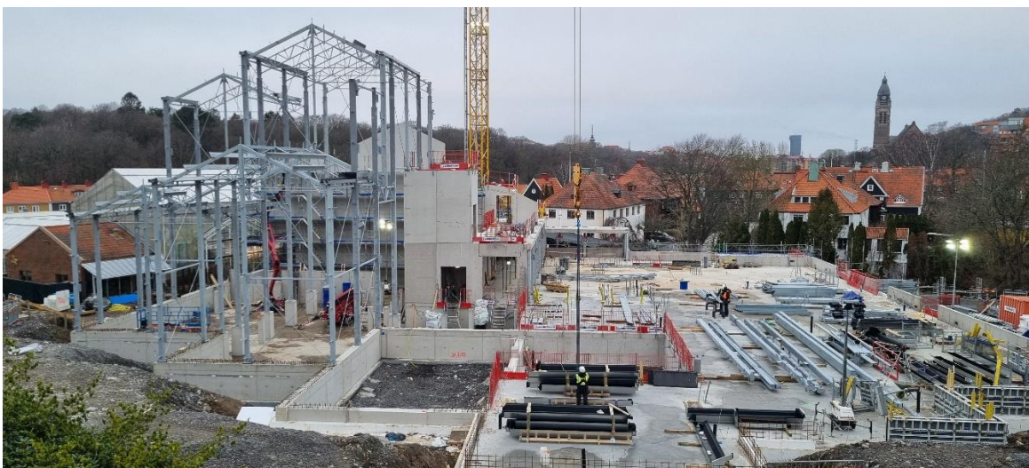
Bild 1. Översiktsbild arbetsområde etapp 2
