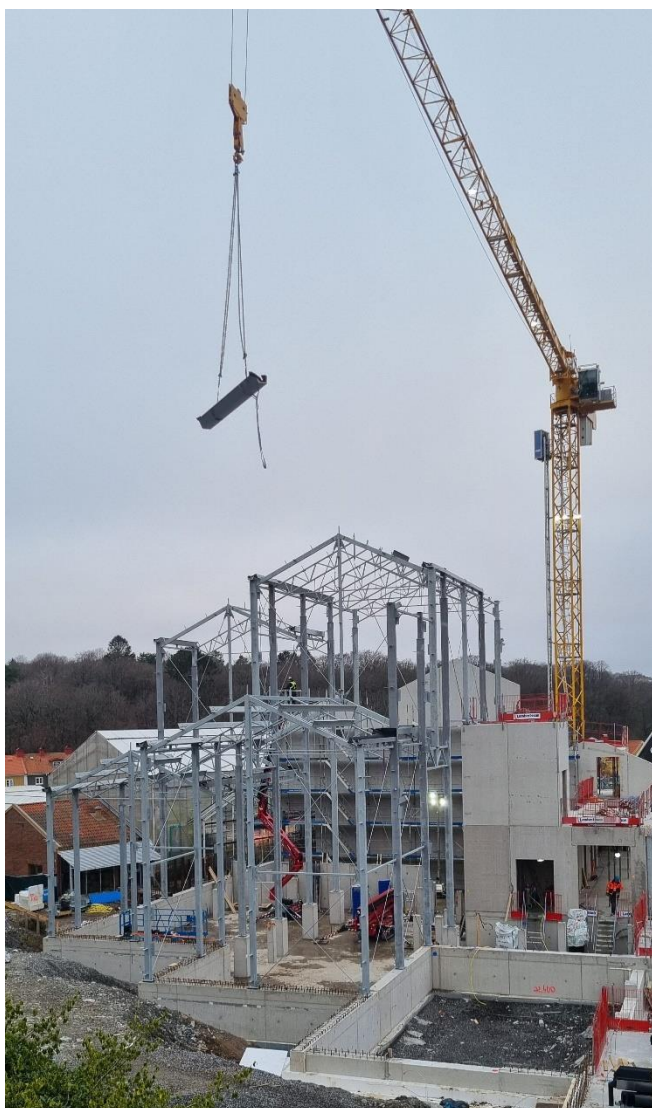
Bild 2. Pågående montering stålstomme
