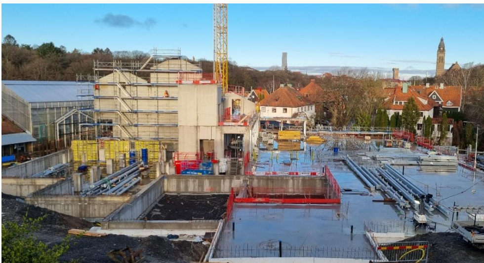
Bild 1. Översiktsbild arbetsområde etapp 2
