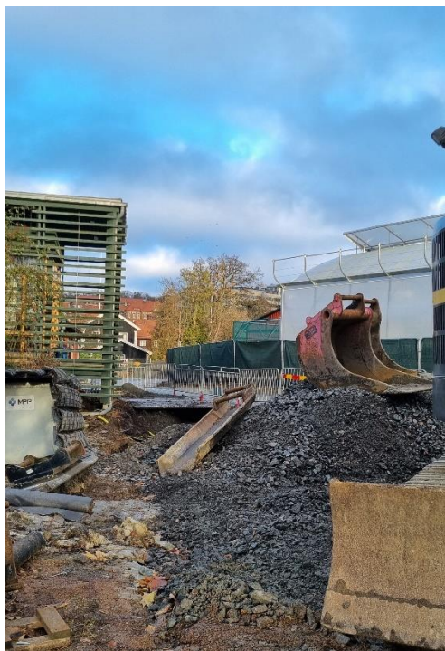
Bild 5. Pågående arbete VA-schaktning
