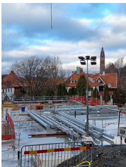
Bild 3. Stålstomme som snart skall börja monteras
