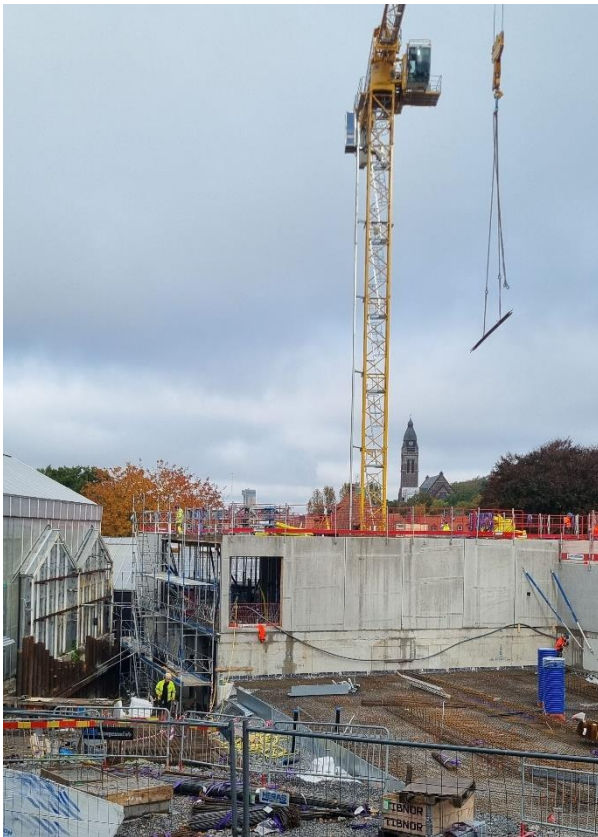
Figur 2. Arbete med plattbärlag våning 3
