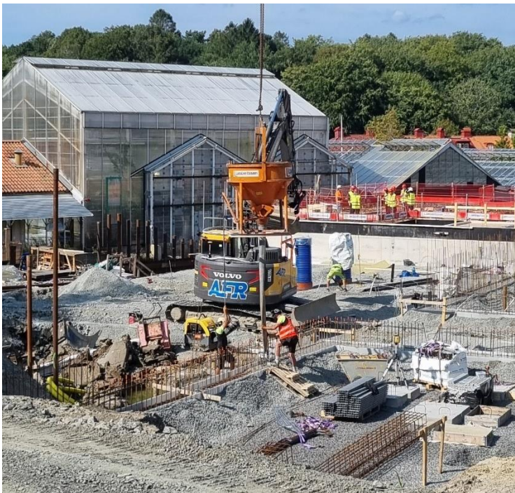
Figur 2. Gjutning källarväggar pågår
