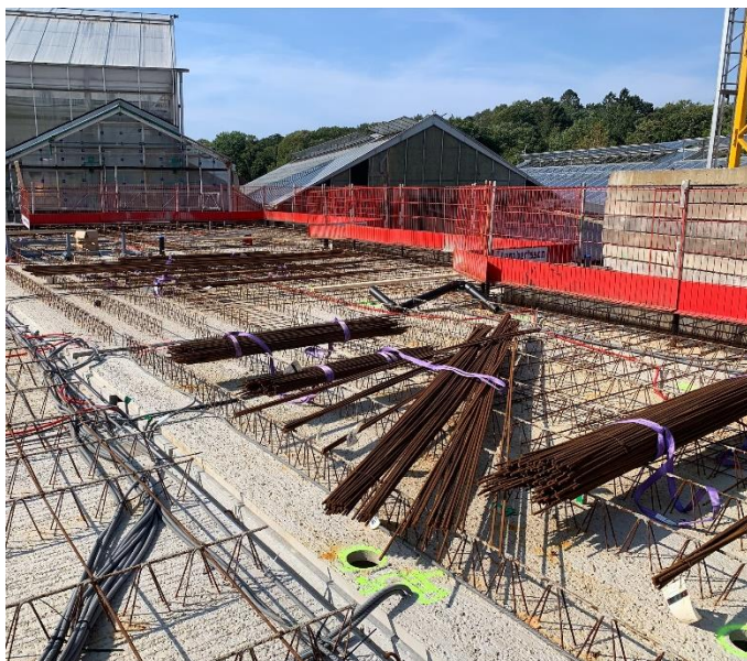
Figur 4. Förberedelse montering plattbärlag
