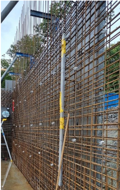
Figur 5. Armerad källarvägg som väntar på gjutning
