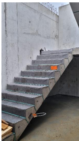
Figur 2. Trappa från källarplan till plan 1 monterad
