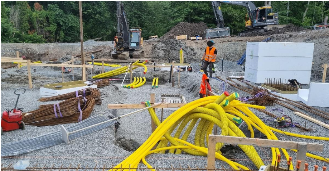
Figur 3. Pågående arbeten och förberedelse för gjutning av resterande platta etapp 2
