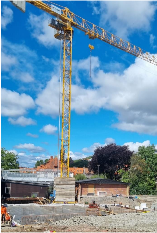
Figur 2. Första delen gjutning av platta etapp 2 klar
