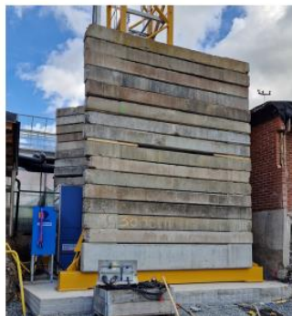
Utsida kranfot, 100 ton motvikt, 50 påvardera sida om masten.
