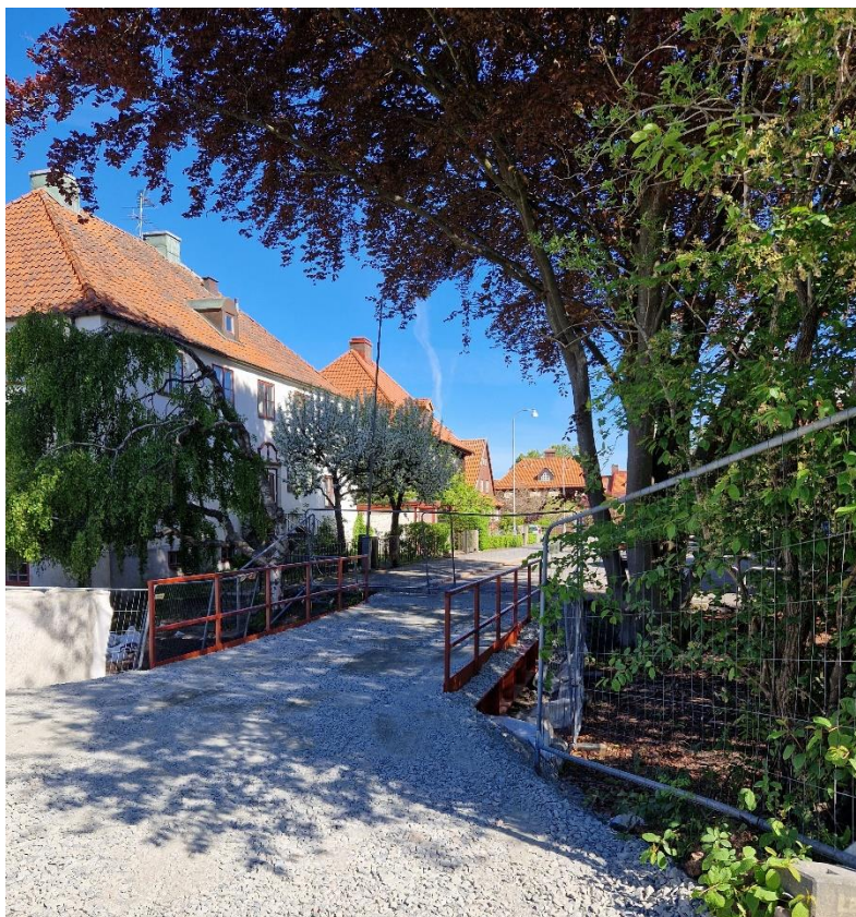
Figur 4: Tillfällig bro från Malmgårdsgatan in mot arbetsområdet
