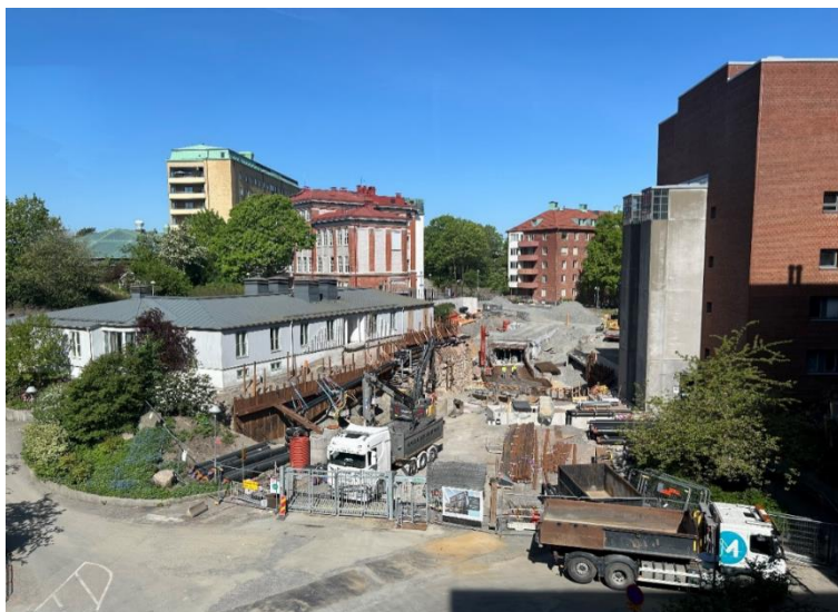
Kulvertarbeten vid korsningen mellan Bruna och Röda stråket
