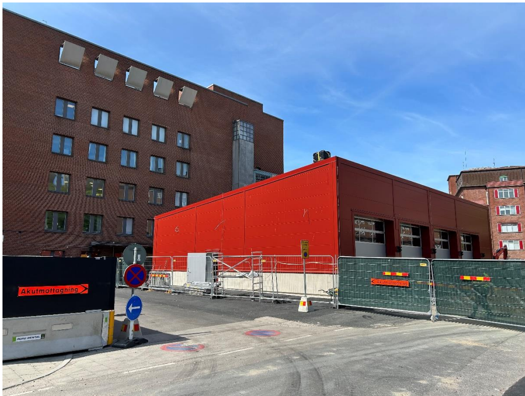
Provisorisk ambulanshall byggs vid Gröna stråket.
