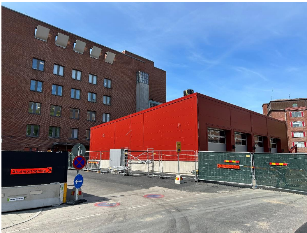
Provisorisk ambulanshall byggs vid Gröna stråket.
