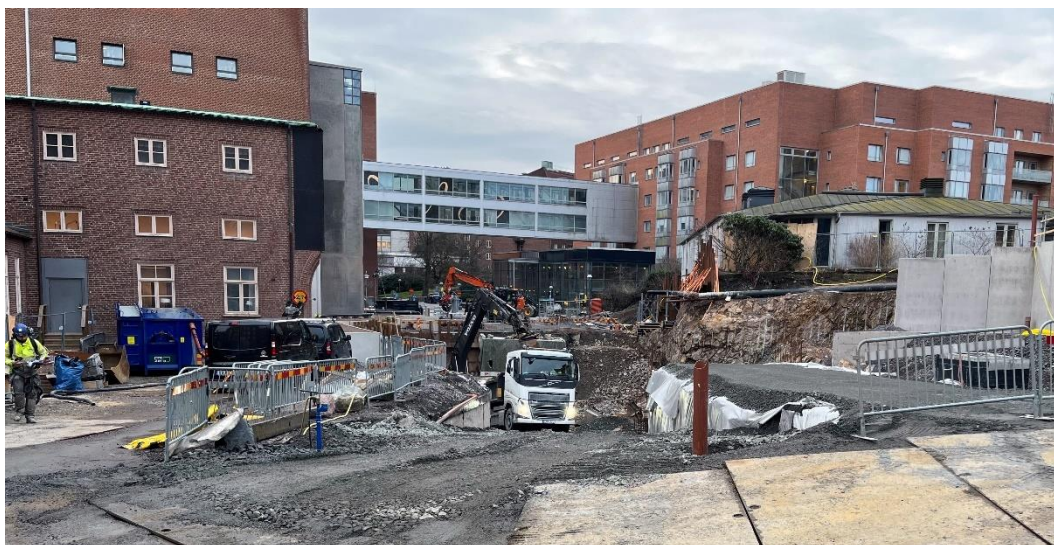
Byggnation av kulvert mellan Gröna och Bruna stråket (H)
