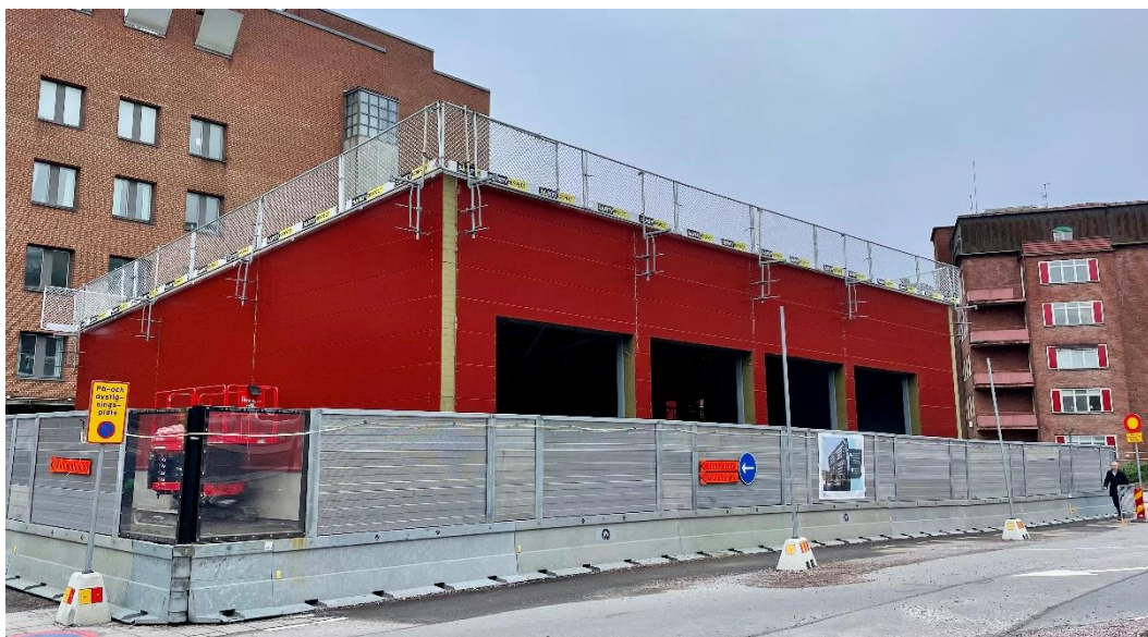
Provisorisk ambulanshall byggs vid Gröna stråket (I)
