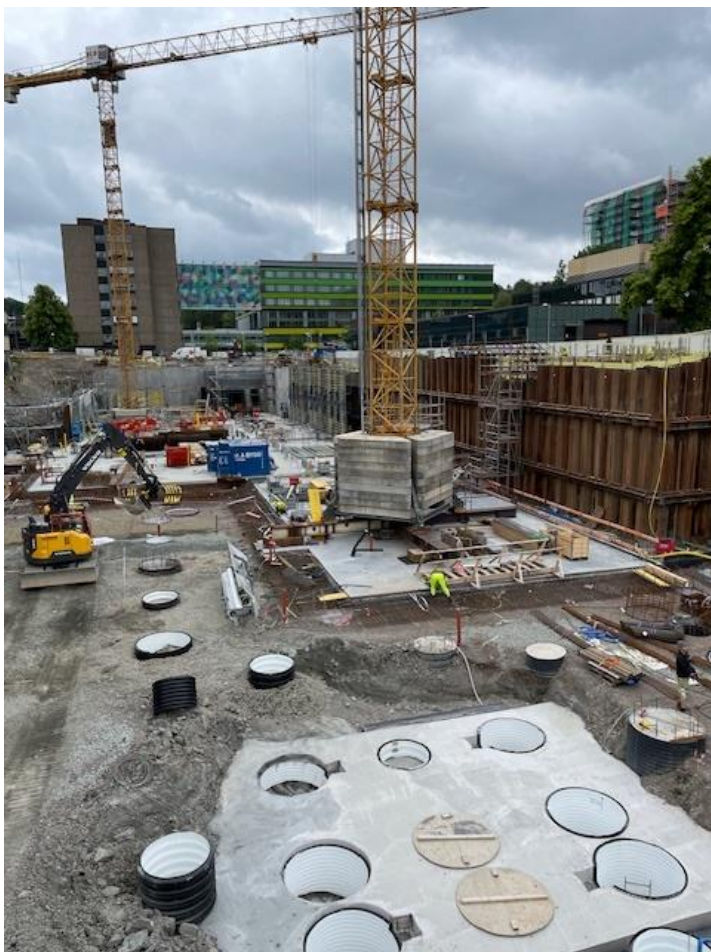
Bild 1 Sista delen i norr, där grundläggningsarbeten pågår.
