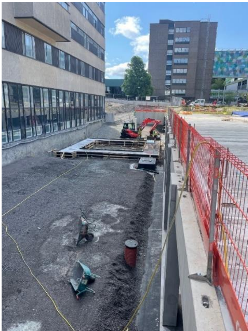
Bild 2 Kranfundament
