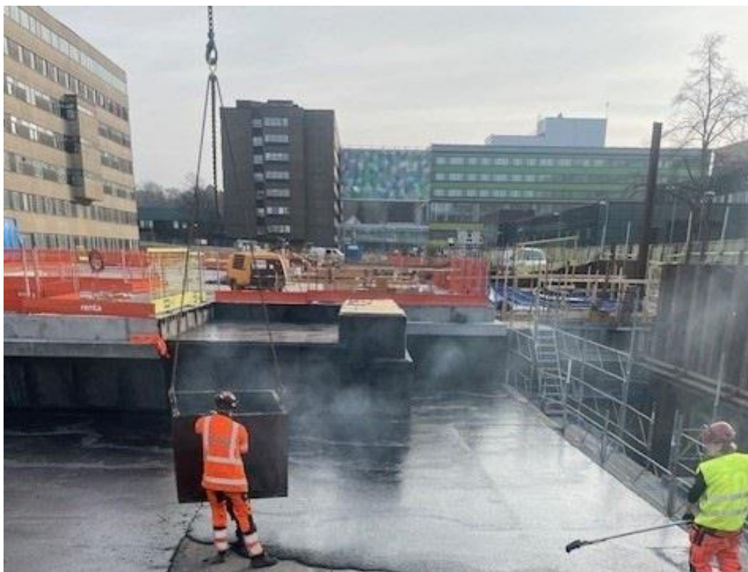
Bild 1 Läggnig av tätskikt på kulvert
