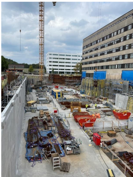
Bild 1 Översiktsbild från söder
