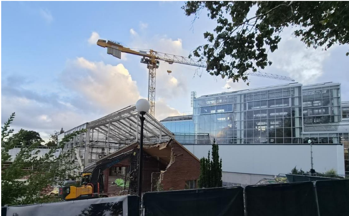
Figur 1. Rivning befintliga gamla växthus påbörjad
