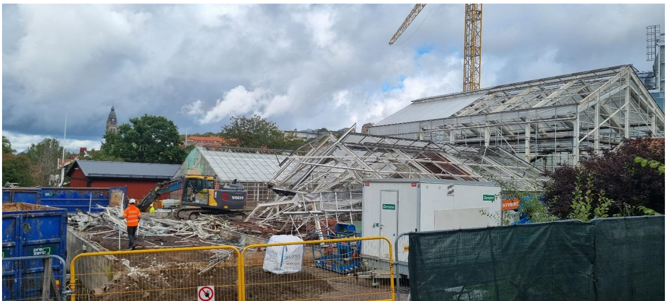
Figur 1. Rivning befintliga gamla växthus påbörjad
