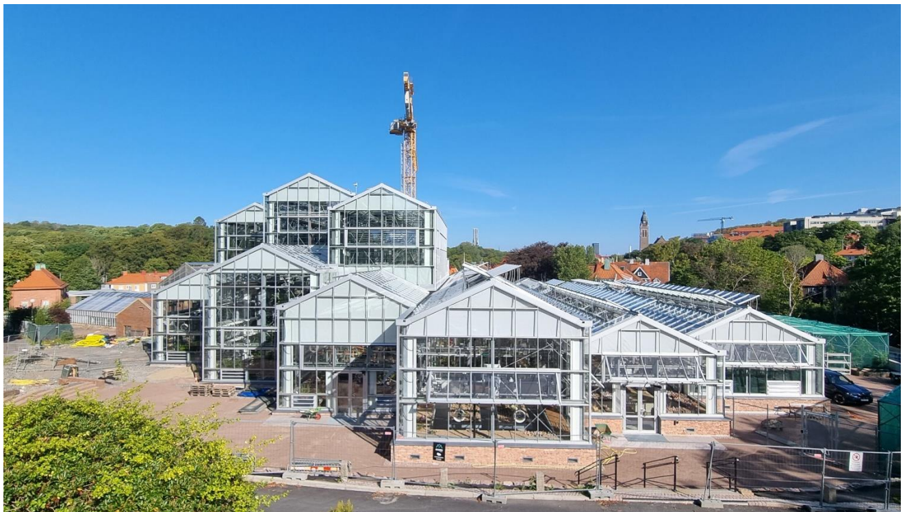
Figur 1. Vy mot söder
