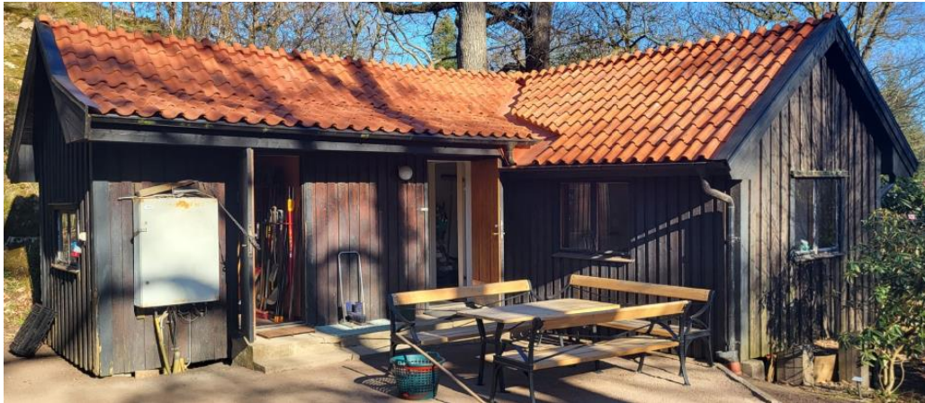
Figur 7. Alpstugan som ska renoveras
