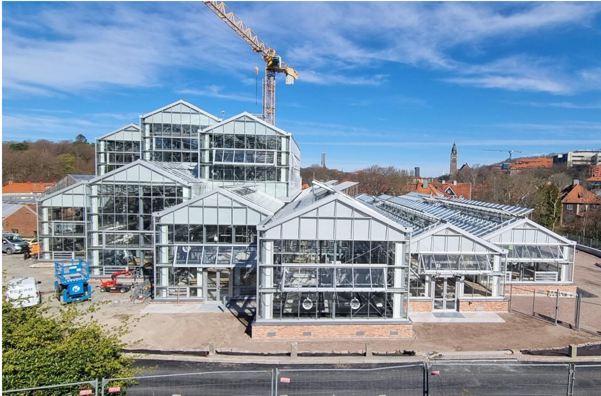
Figur 1. Vy mot söder
