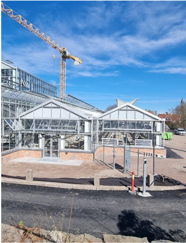
Figur 2. Grindar på plats och ny transportväg asfalterad
