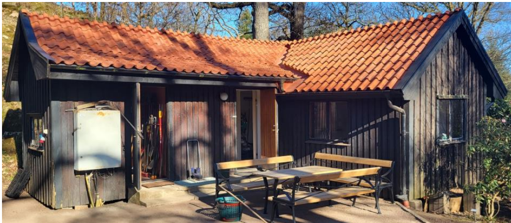
Figur 6. Alpstugan som ska renoveras
