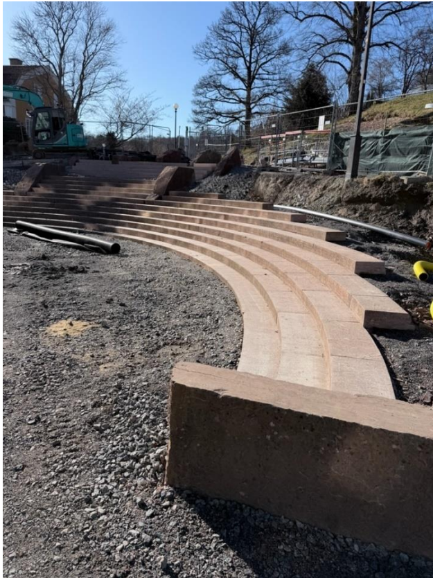
Figur 3. Återbrukad kalkstenstrappa
