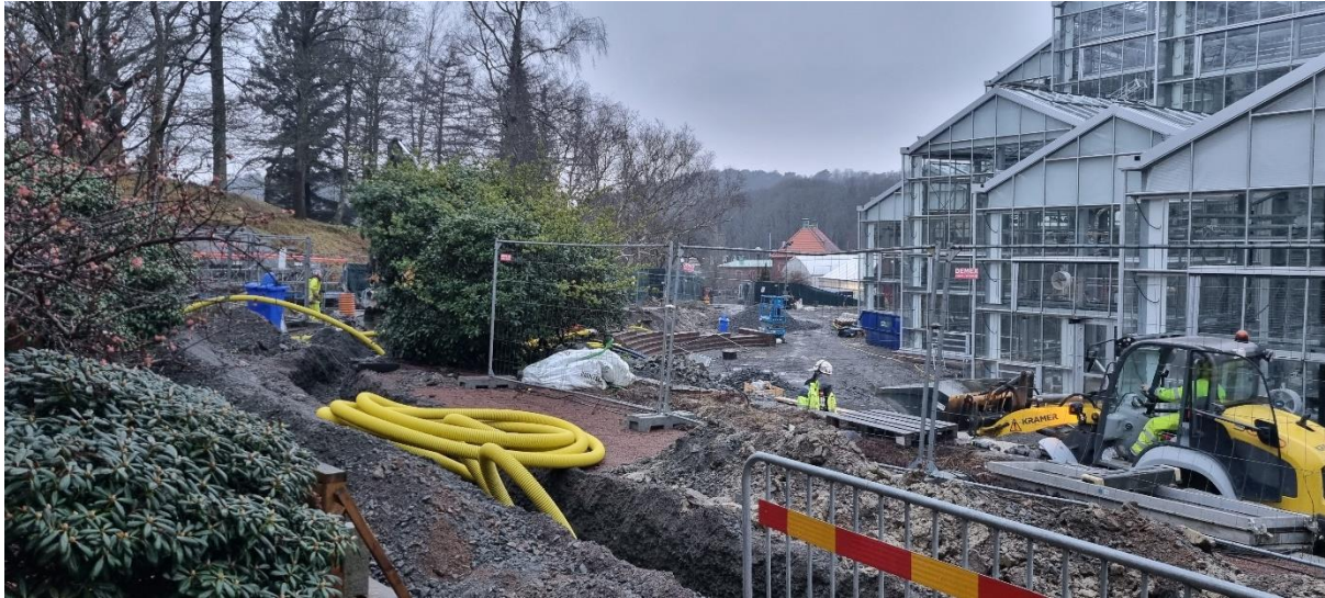
Figur 2. Schaktarbete utanför Stora Änggården pågår
