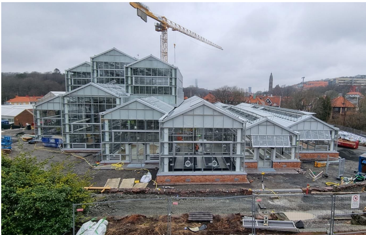
Figur 1. Vy mot söder
