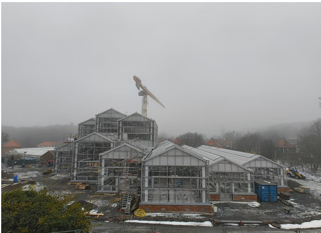
Figur 1. Vy mot söder
