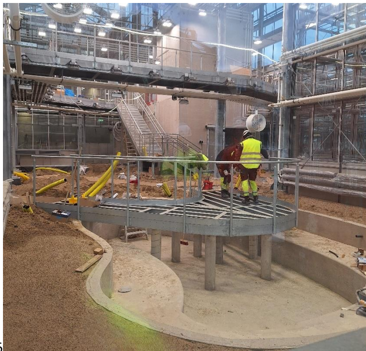
Figur 4. Bro över damm i avdelning djungel & ruin är monterad
