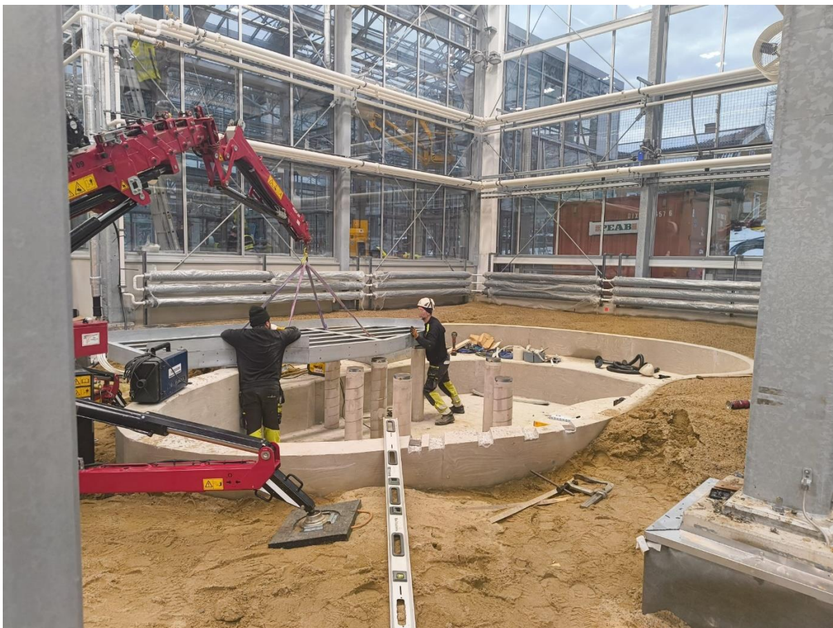
Figur 3. Pågående montage av bro över damm i avdelning djungel och ruin
