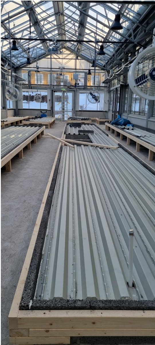
Figur 4. Arbete med montage LECA-blocksbord
