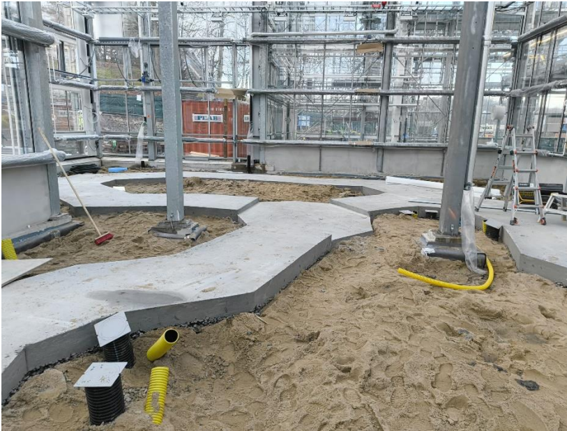
Figur 2. Färdiggjuten gångväg i avdelning öken och brand
