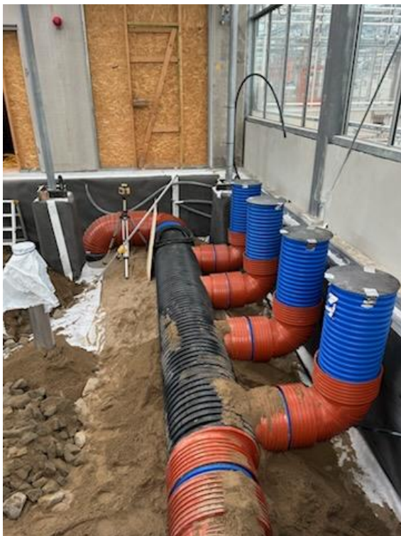
Figur 6. Ventilationsrör i djungel/ruin
