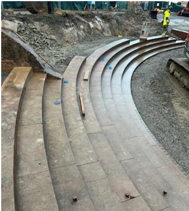
Figur 8. Uppbyggnad av kalkstenstrappan pågår
