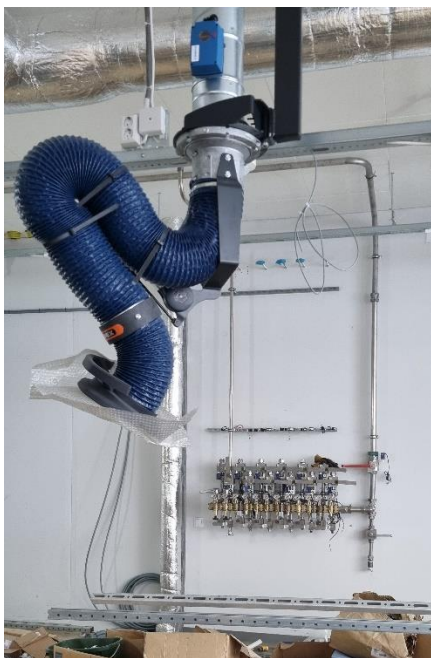
Figur 5. Punktutsug och sprinklercentral i arbetsrum plan 2
