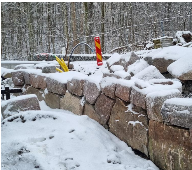
Figur 7. Pågående montage av återbrukad kallmur
