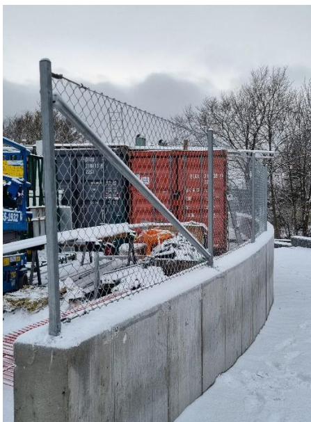
Figur 8. Nätstängsel på betongstödmur vid försörjningsväg
