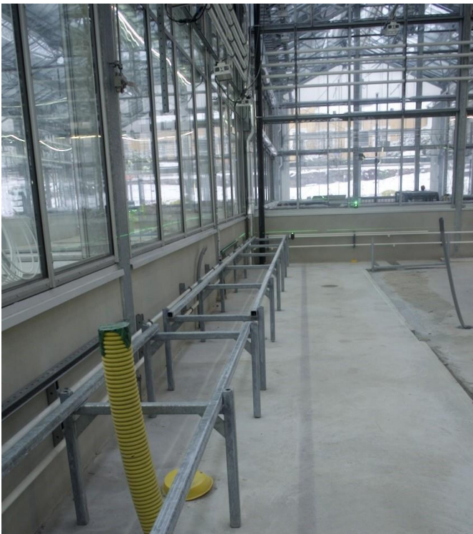
Figur 3. Påbörjat montage växtodlingsbord
