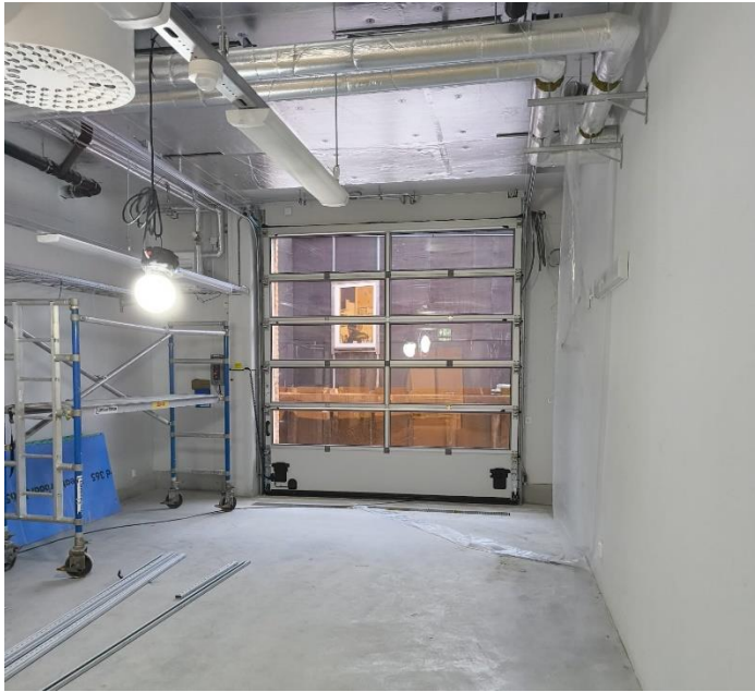
Figur 4. Takskjutport installerad i jordblandningsrum
