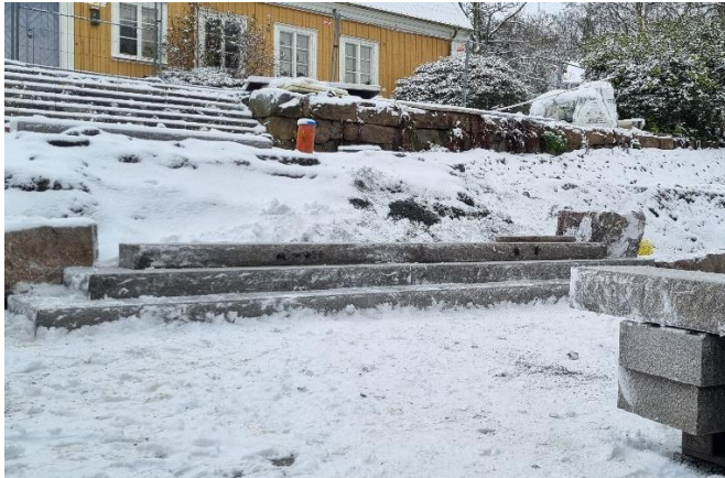
Figur 6. Montage av granittrappa
