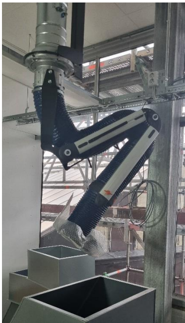
Figur 5. Monerat punktutsug i arbetsrum på plan 2
