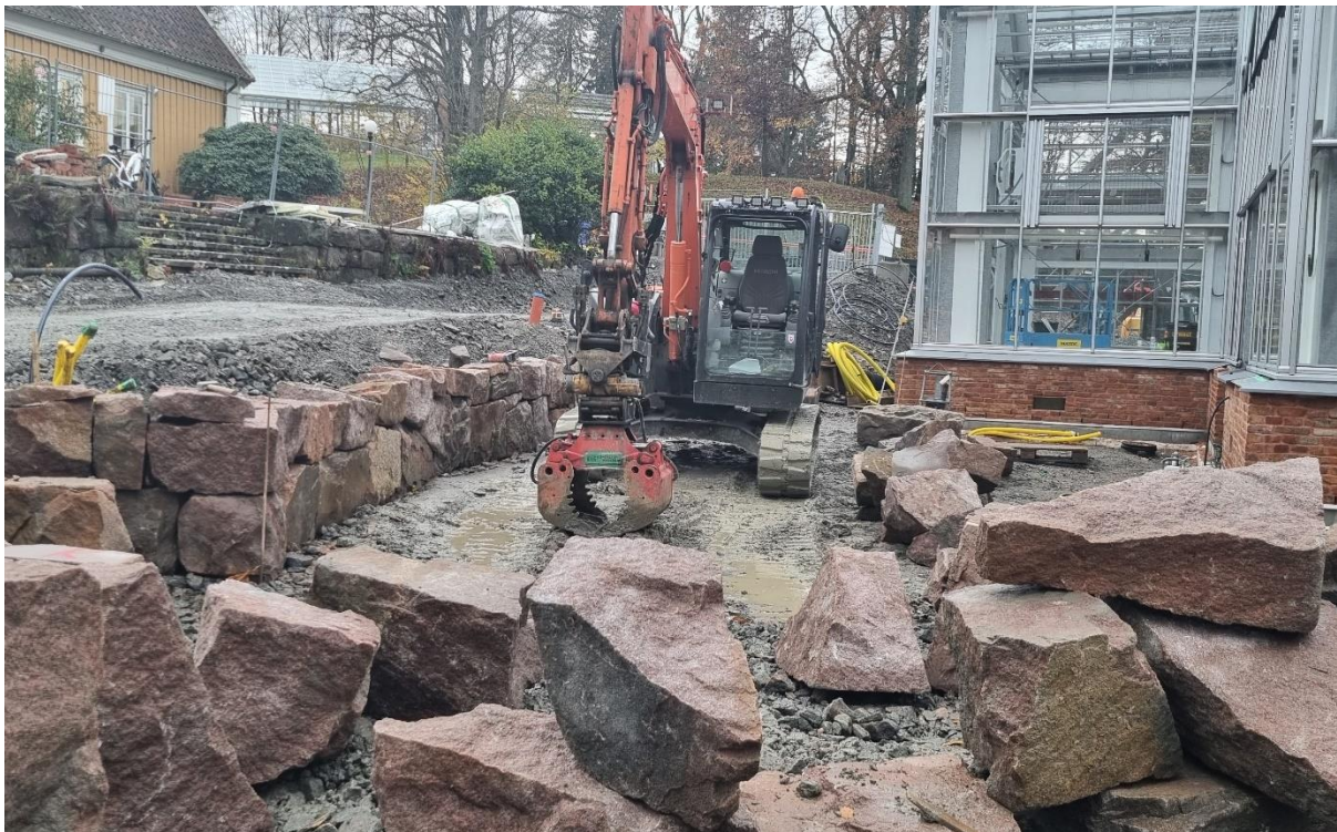
Figur 7. Pågående montage av återbrukad kallmur
