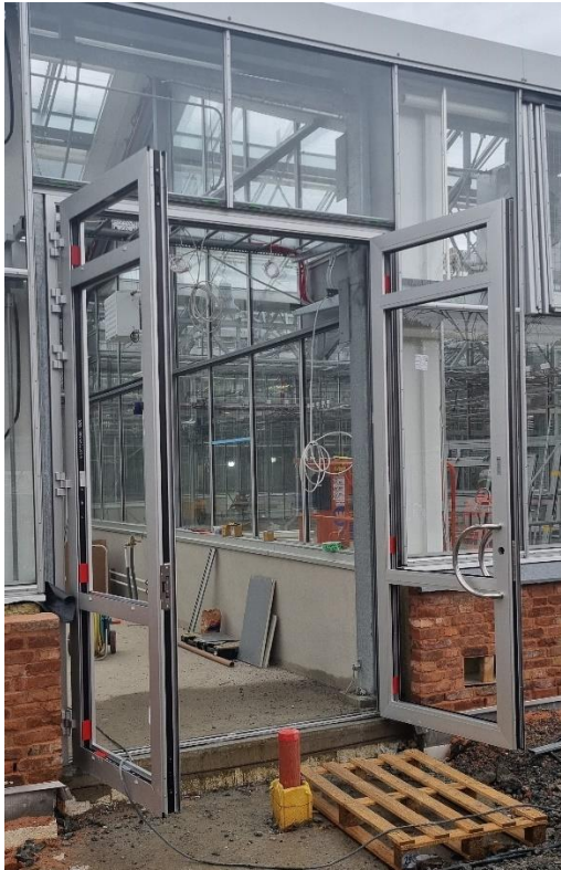
Figur 6. Monterade dörrar på baksidan
