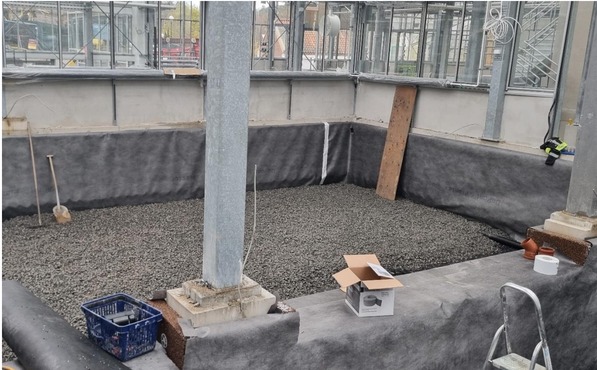
Figur 3. Påfyllt med grus i avdelning öken & brand
