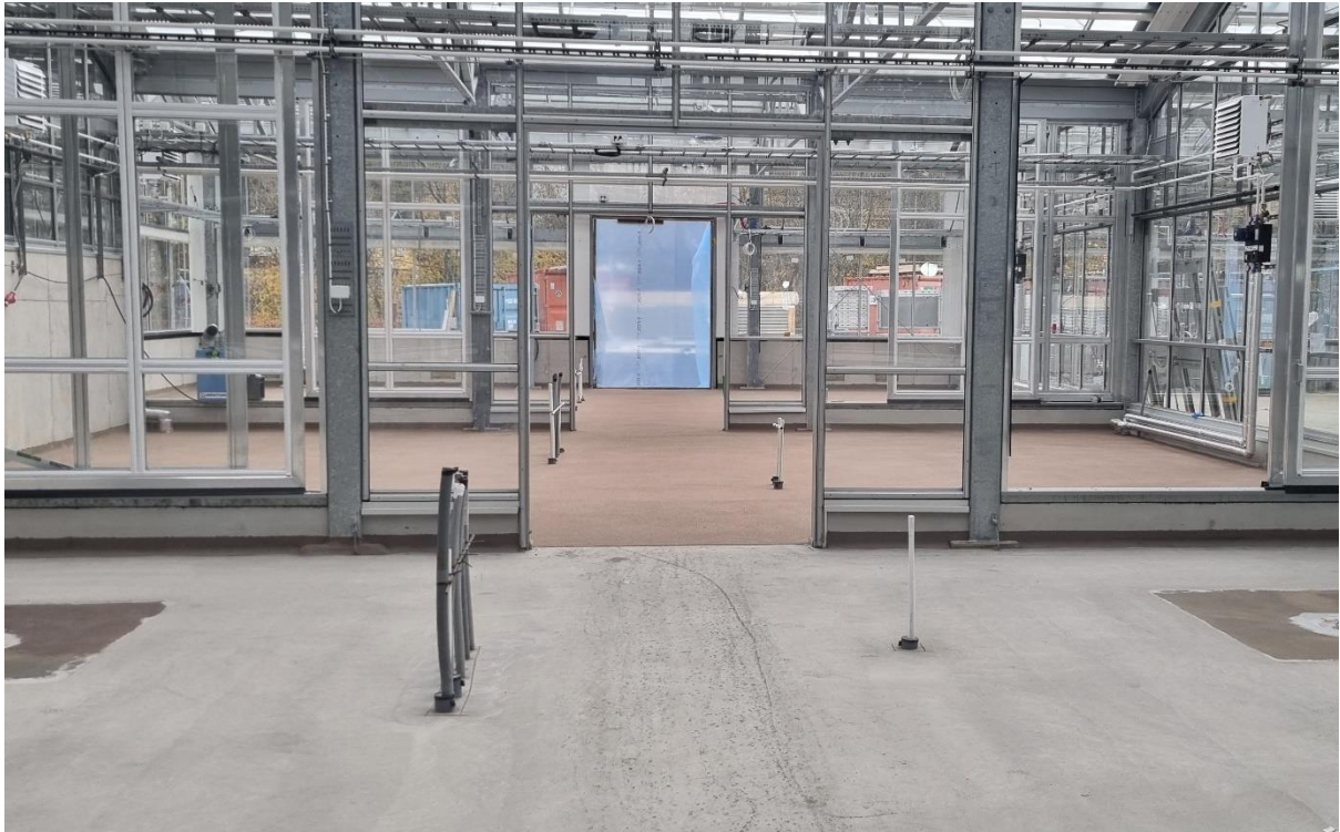
Figur 4. Färdigt massagolv i förkningsavdelningar
