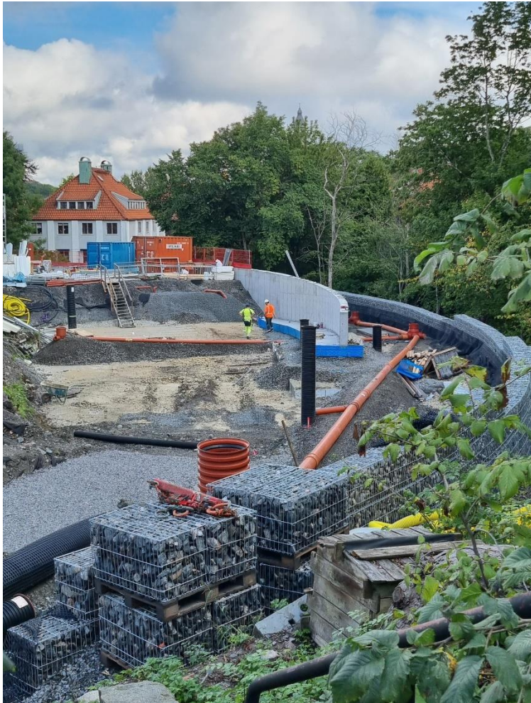
Figur 2. Pågående arbete med gabionmur
