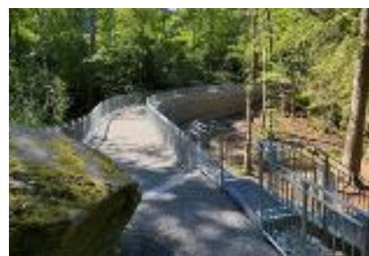
Skyfallsanläggning vid Östra sjukhuset
