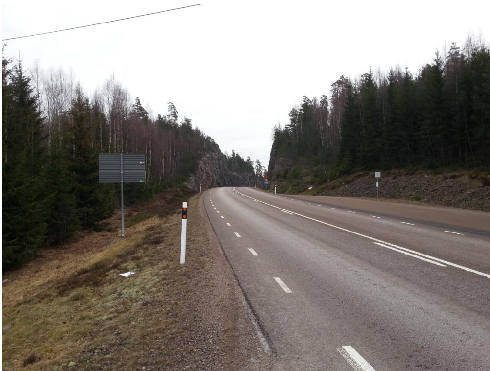
Figur 11. Vy åt öster på väg 164. Vägen skär igenom berget, sikten är begränsad för ankommande och utsvängande trafik och passager till busshållplatsen saknas.
