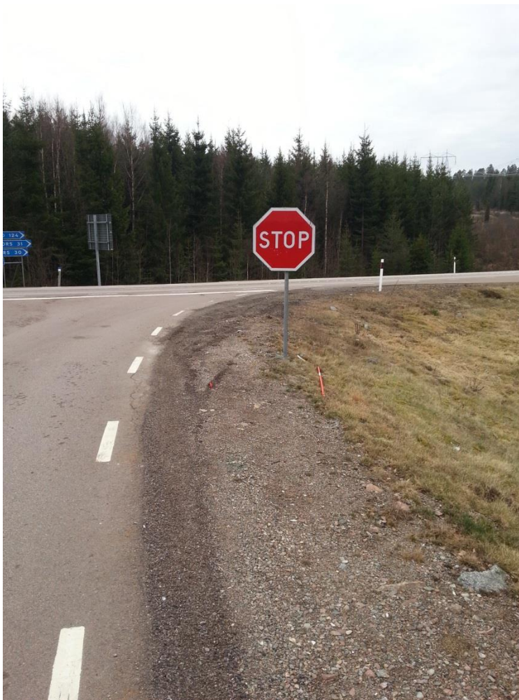
Figur 12. Fordon kör utanför körbana vid sväng in och från 2256.
