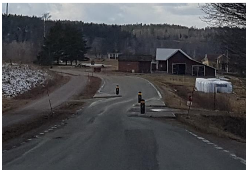
Figur 12 Hastighetsdämpande åtgärd i form av refug och pollare
