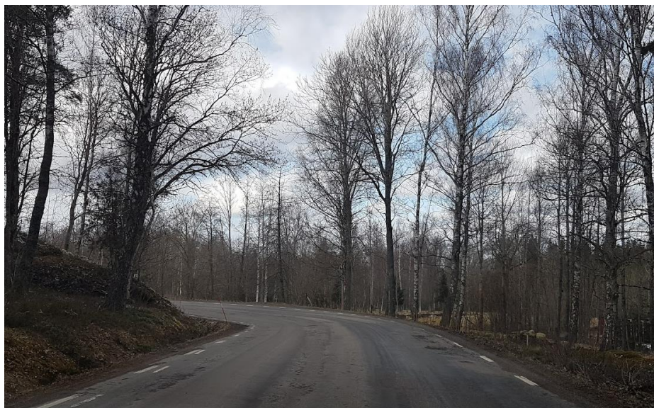
Figur 18 Dålig sikt, problem pga kurva och vägslänt och växtlighet. Även hinder i säkerhetszonen
