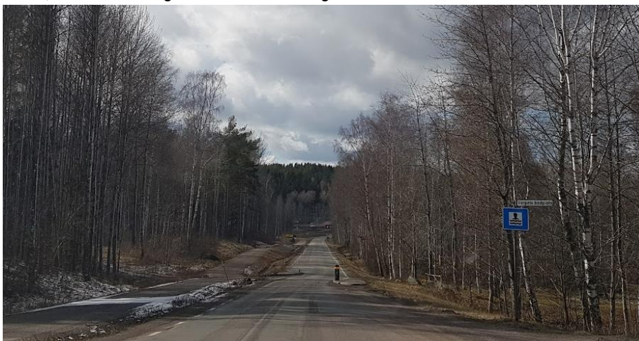
Figur 14 Exempel på hastighetsdämpande åtgärd som är placerad på krön och därmed svår att se, varnas med vägmärke för avsmalning
