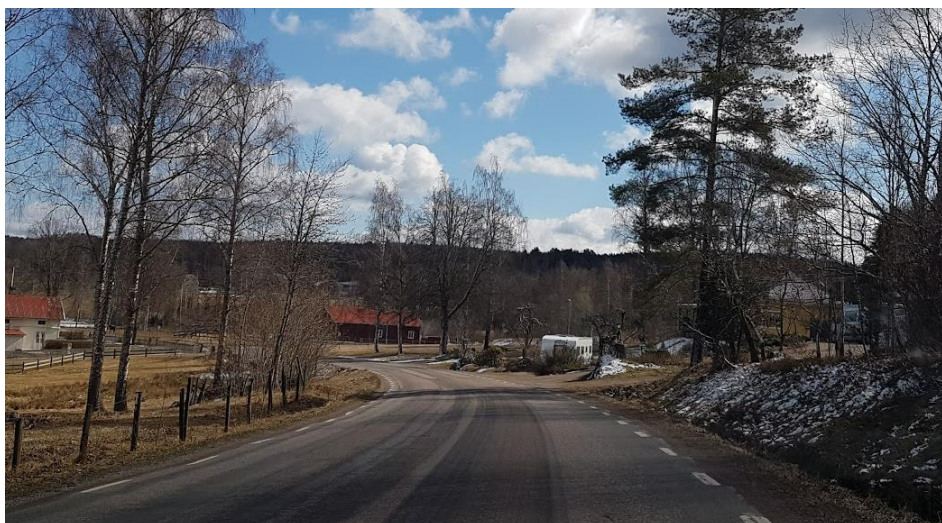
Figur 19 Dålig sikt pga kurva i kombination med växtlighet
