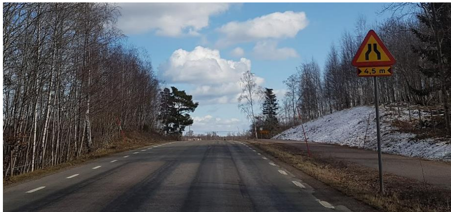
Figur 14 Exempel på hastighetsdämpande åtgärd som är placerad på krön och därmed svår att se, varnas med vägmärke för avsmalning
