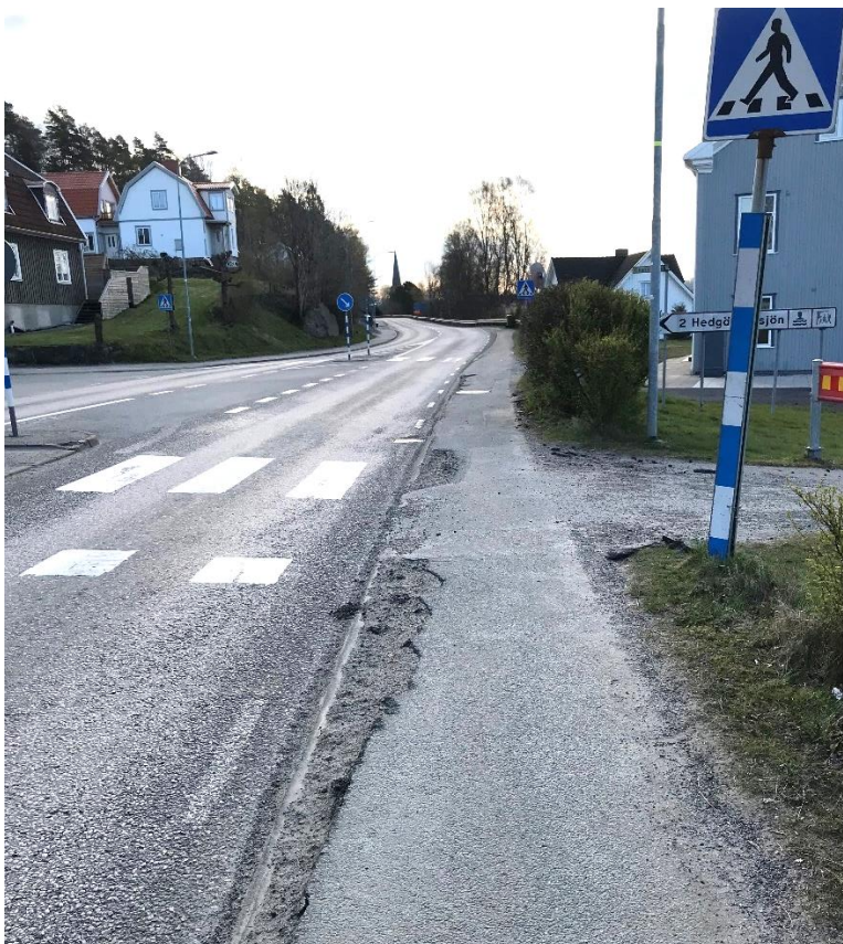
Figur 9 Sönderkörda kantstenar, närmast västra övergångsstället. Foto: COWI
