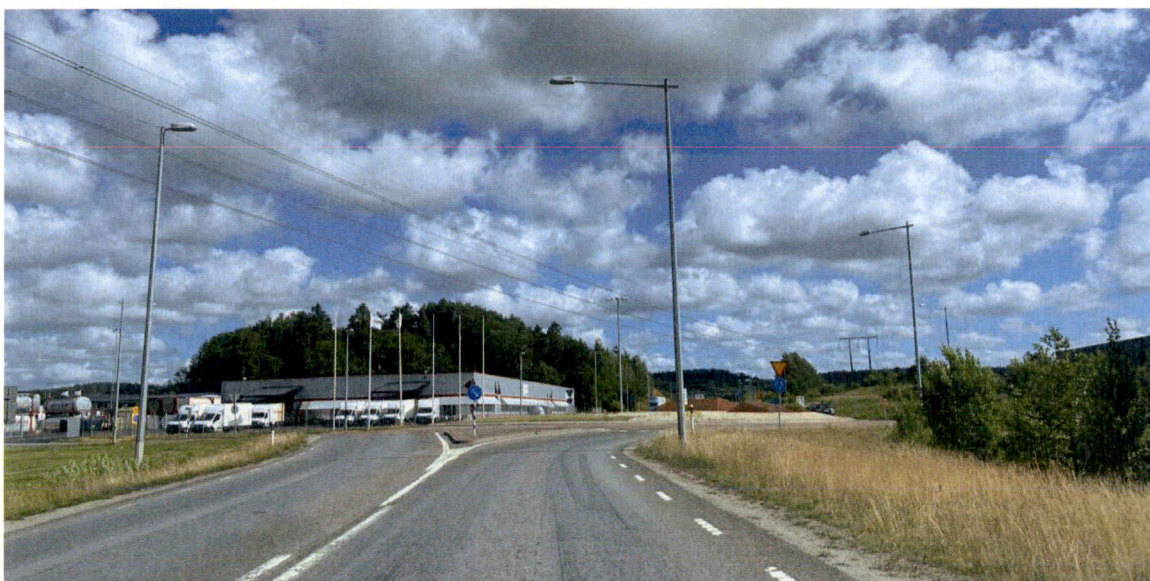
Figur 28 Cirkulationsplatsen vid korsningen med Munkerödsvägen
