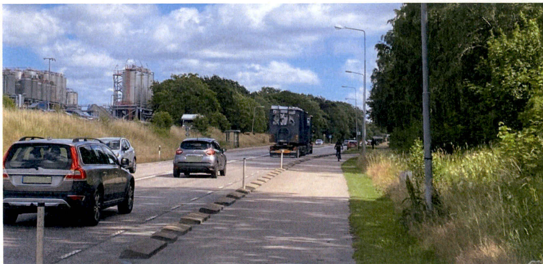
Figur 22 Foto GC-bana med GCM-stöd som avgränsning mot körbanan.
