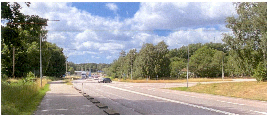
Figur 21 Foto korsningen med Stripplekärrsvägen och Mariavägen
