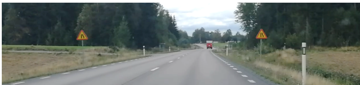
Figur 9 Strax söder om svackorna, ungefär mitt på utredningssträckan, smalnar vägen av något vid en bank och mitträfflingen upphör.
