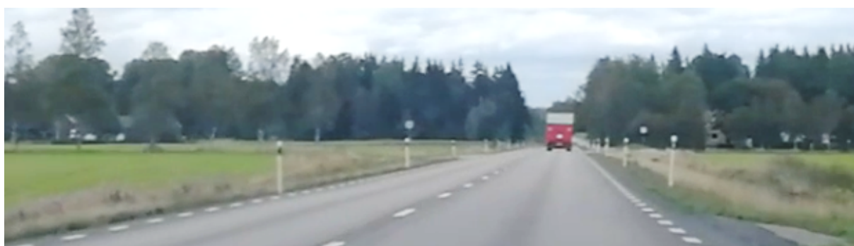
Figur 8 Sträckan mellan Järbo skola och svackorna (södra halvan av sträckan). Fräst mitträffling finns.
