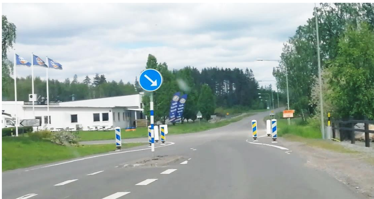
Figur 8 Bäckedalsvägens anslutning till Mariestadvägen sedd från söder. Söder om korsning finns en hastighetsdämpande avsmalning kompletterad med mittrefug. På norra sidan korsningen finns ingen hastighetsdämpande åtgärd. I uppførsbacken kan gångbanan "Lennarts väg" skymtas, men det finns ingen gångbana eller gångpassage som förbinder den med övriga gångbanor.
