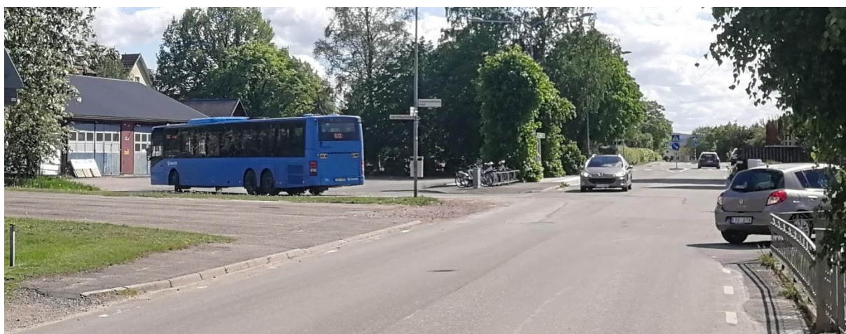
Figur 10 Hållplats Timmersdala sedd från norr från Mariestadsvägen. Bussen håller på att svänga runt för att angöra hållplatsen på insidan, men väderskyddet är vänt ut mot Mariestadsvägen. Hållplatsens plattform är inte utformad så att bussen kan angöra den med alla dörrar utan att backa.
