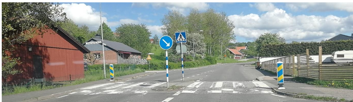
Figur 13 Befintlig passage sydväst om skolan är i dåligt skick.
