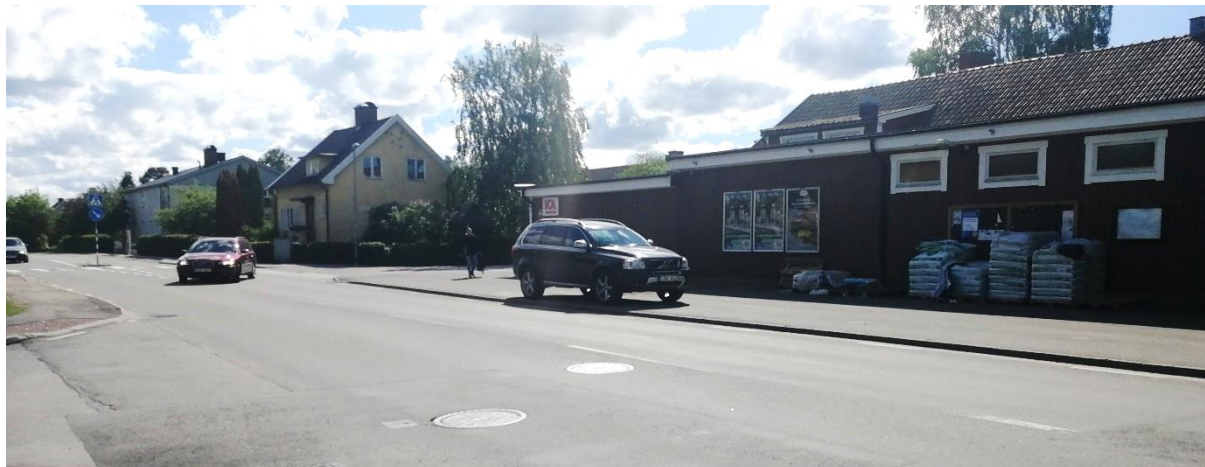
Figur 12 Vid Ica är det ett långt uppehåll i gångbanan på östra sidan på grund av att Torggatans anslutning är mycket vid. På Ica-butikens fastighet på västra sidan finns det en asfalterad yta som liknar en gång- och cykelbana men som används dels som parkeringsplats och dels som uppläggningsplats för varor såsom jordsäckar.
