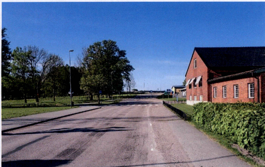
Figur 7 Begränsad sikt för södergående trafikanter på Järnvägsgatan till följd av att polishuset skymmer cyklister som kommer från höger längs Storgatan och ska korsa Järnvägsgatan. (foto: Johanna Sandström)
