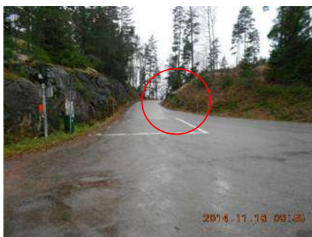
Bild 6. Anslutning och utfart till färjeterminal Jaren samt del av bergsklack, som behöver schaktas/sprängas.
