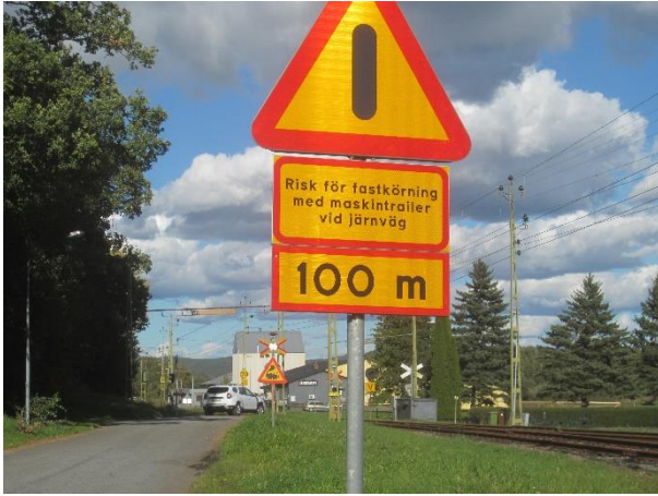
Varningsskylt vid Linnevägens plankorsning
