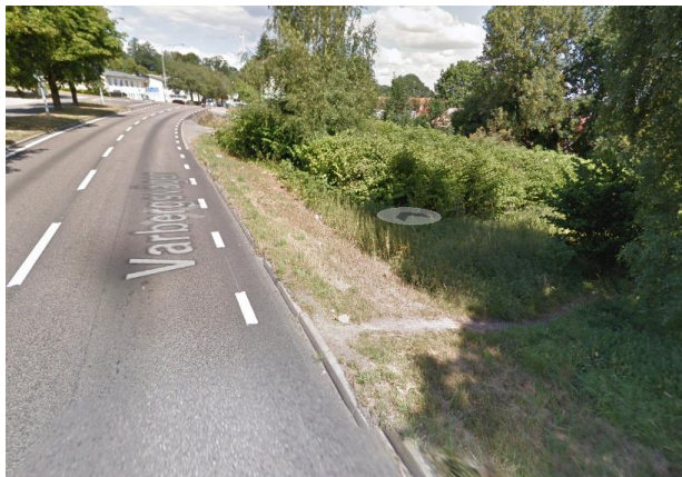
Här finns behov av gångbana, stigen leder till stationen
