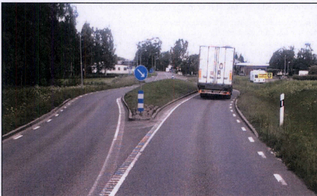
Figur 52. Mittrefug och avsmalnade körfält i södra delen av tätorten för att få fordonen att sänka hastigheten. Foto: Trafikverket.
