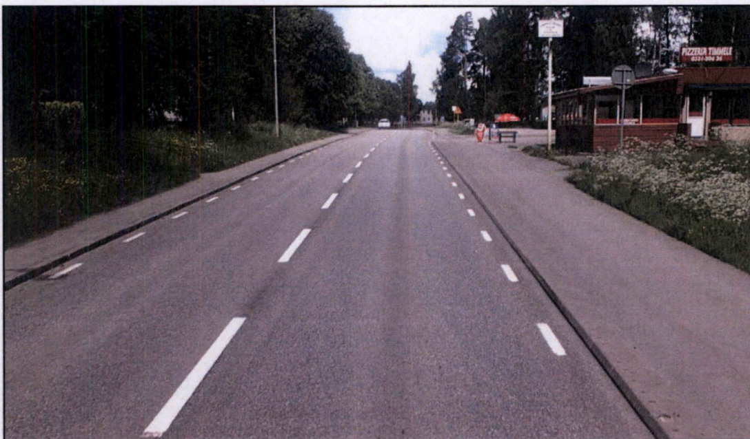
Figur 9. Gång- och cykelväg, separerad från väg 46 med GCM-stöd, längs södra delen av väg 46 genom Timmele. Foto: Trafikverket.
