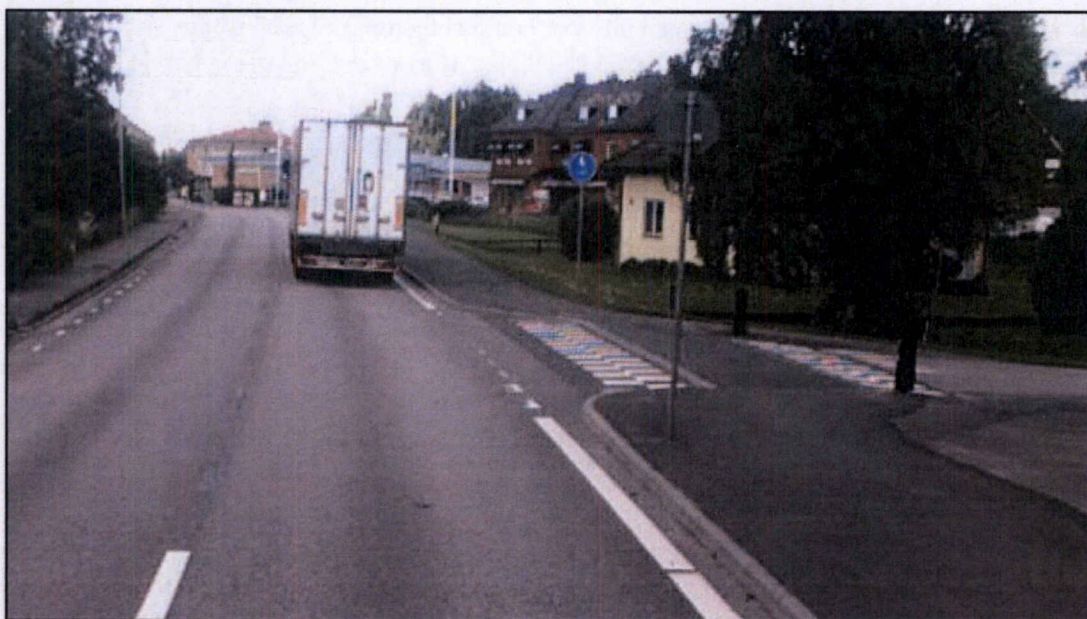
Figur 33. Gång- och cykelvägen har utformats med förhöjda passager över vägar och gator som ansluter till väg 46. Foto: Trafikverket.
