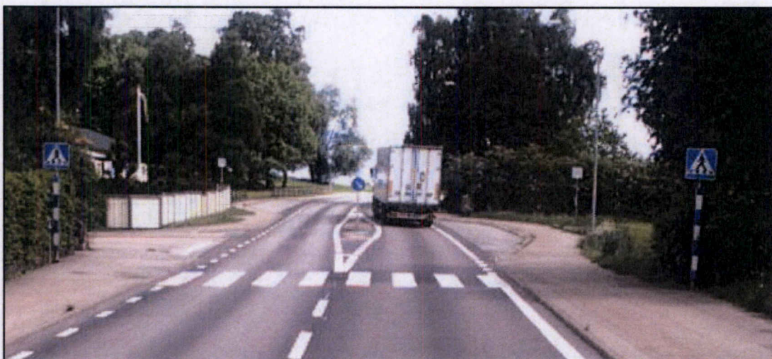
Figur 21. Övergångstället i norra delen av Trädet, söder om korsning med Torngatan. Mittrefug finns norr om samma korsning. I bilden syns även hållplats Torngatan. Foto: Trafikverket.
