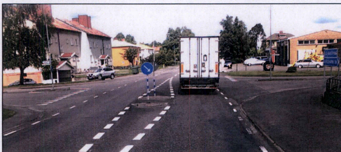
Figur 46. Passagen över väg 46 är placerad delvis mitt i en korsning med bristande koppling till trottoarerna på respektive sida av väg 46. Foto: Trafikverket.
