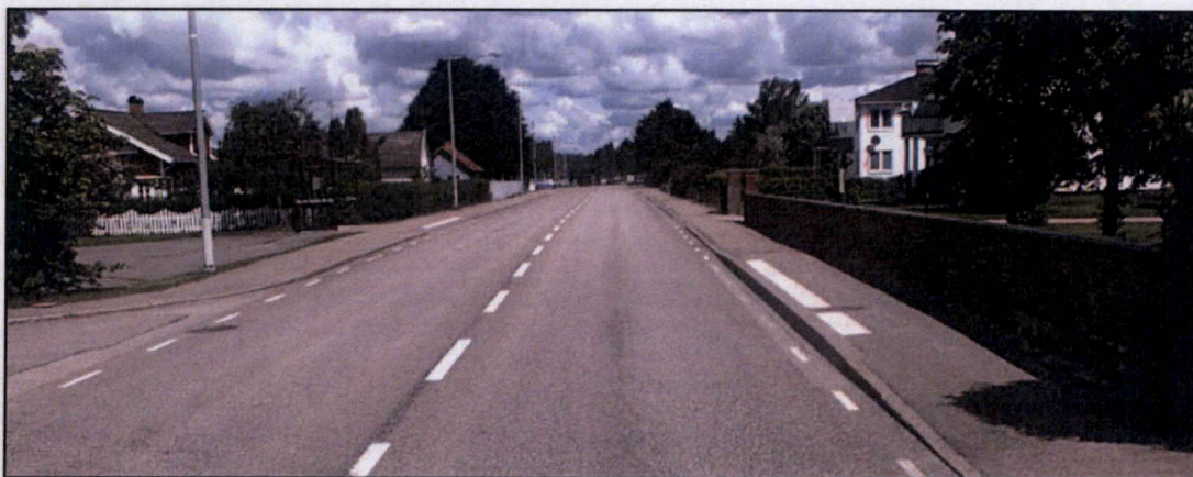
Figur 12. Hållplats Timmele. Foto: Trafikverket.
