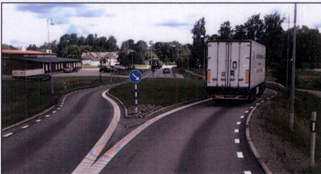
Figur 28. Mittrefug och avsmalnade körfält i södra delen av Trädet för att få fordonen att sänka hastigheten. Foto: Trafikverket.
