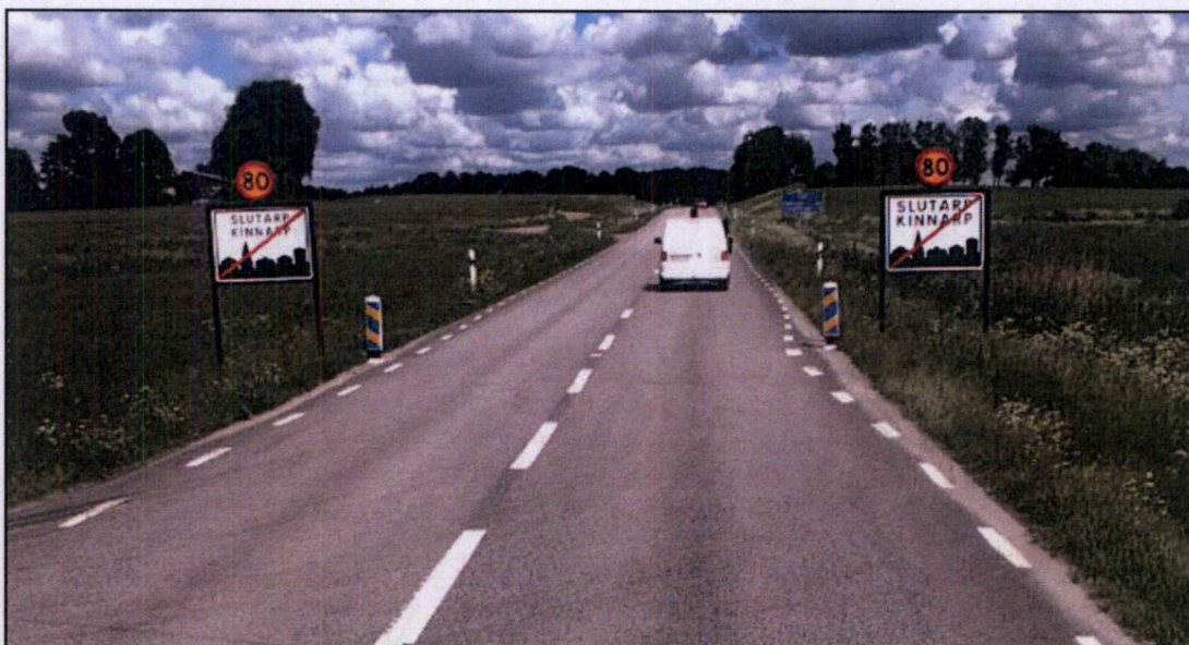
Figur 53. Avsmalning av körfält i anslutning till tätortsportalen i norra delen av tätorten Kinnarp-Slutarp. Foto: Trafikverket.
