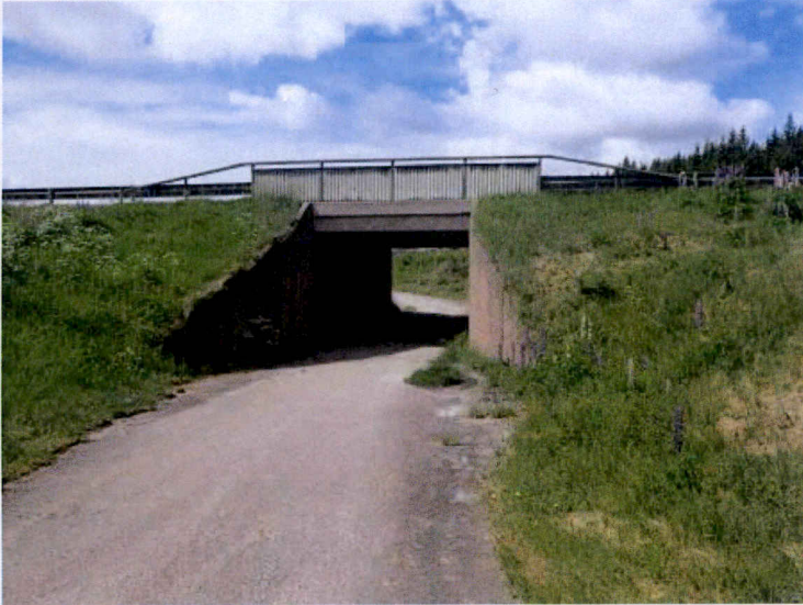
Figur 9 Cykelport under väg 27.
