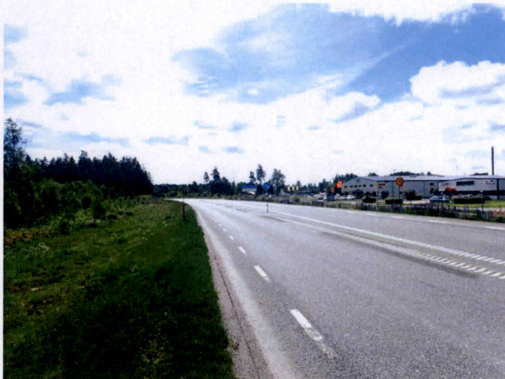
Figur 13 Gräsklädda slänter, diken och befintlig mark utmed väg 27 vid korsningen i Tranemo – sedd mot söder.
