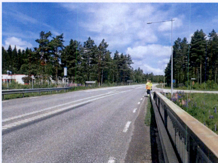
Figur 8 Väg 27 med korsning in till Rosenlundsvägen, sedd mot norr. Vägräcke och gc-port i förgrunden.
