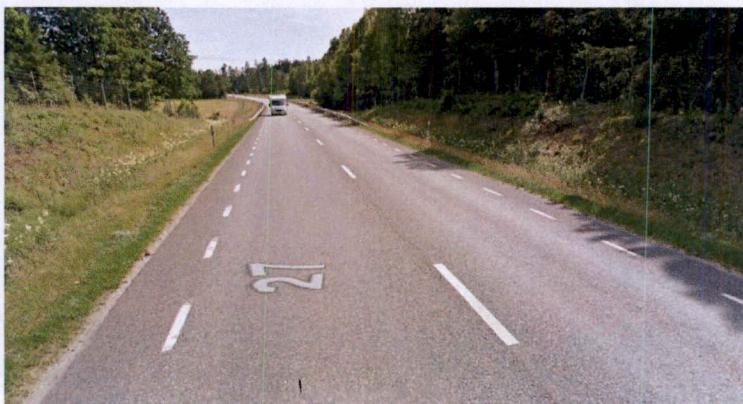
Figur 11 Väg 27 ca 100 meter norr om bäcken, sedd mot söder.
