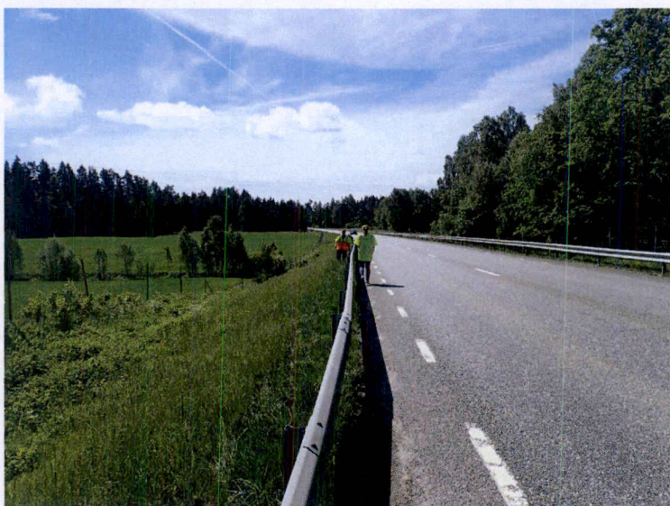
Figur 12 Väg 27 på bank med skyddsräcken över den större bäcken.
